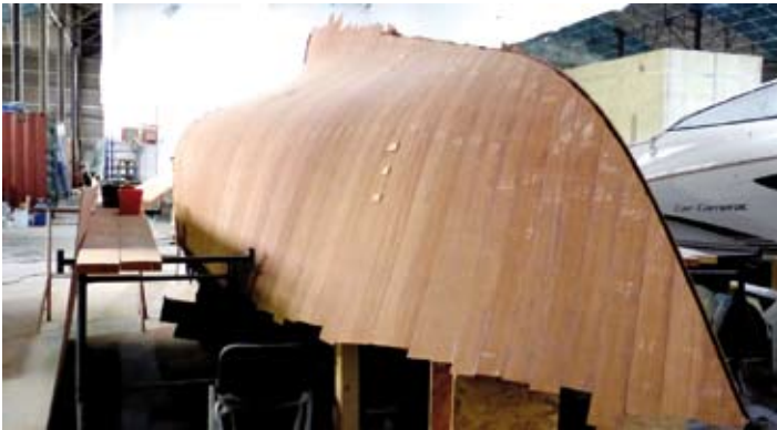
Le premier pli du bordé est en cours de pose.
